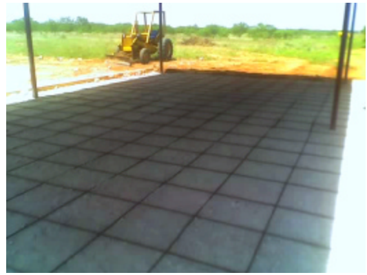
Preparing the to pour the Concrete slab.
