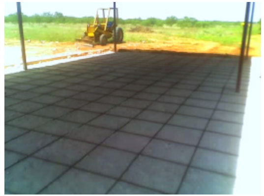
Preparing the to pour the Concrete slab.
